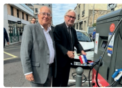
6 septembre - Inauguration d'une borne de recharge à Colombes
